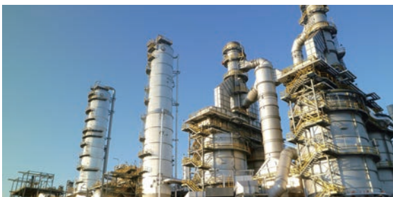
HCPのパラキシレン製造装置
