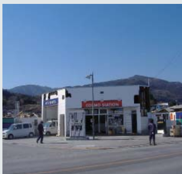
営業再開後のSS (2011年4月5日撮影)
