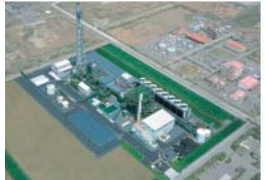
四日市霞発電所
